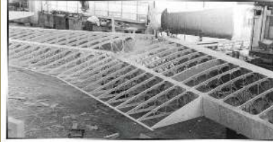
Hava İstasyonu Montajı
